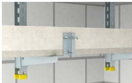
Подвесной потолочный монтаж кабельного канала
