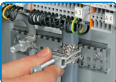
Добавление экранирующей зажимной скобы.
